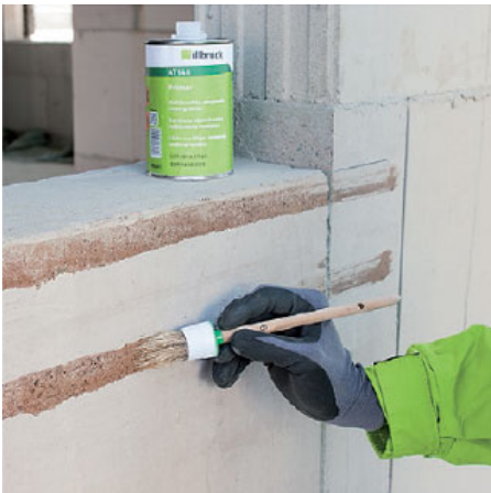
Rys.4 Oczyszczyć również odpowiednio mur i zagruntować go
