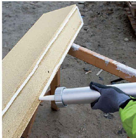
Rys.5 Nanieść klej SP340 o natychmiastowej przyczepności do podłoża na kątownik instalacyjny PR010
