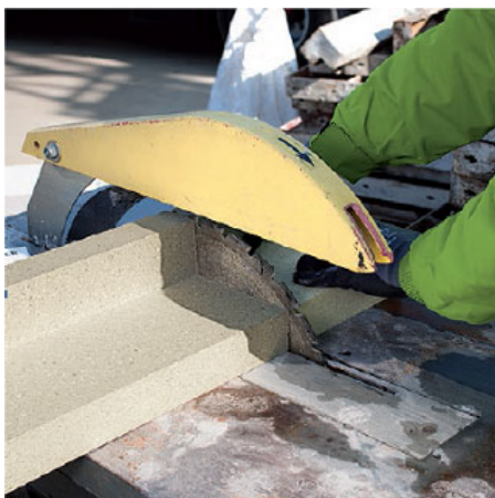
Rys.1 Dociąć kątownik instalacyjny PR010 za pomocą środka AT140
