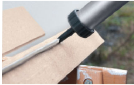
Rys.2 Nanieść klej szybkowiązący SP340 na ucięte profile ramy instalacyjnej
