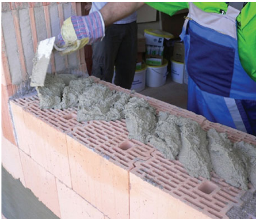
Przygotowanie otworu okiennego zaprawą termoizolacyjną illbruck PR005
