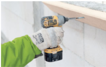
Rys.4 Ustabilizować wkrętami dolny profil ramy instalacyjnej przed przesuwaniem w czasie montażu, a następnie przykleić i ustabilizować pozostałe profile - boki oraz górę
