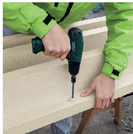
Rys.2 Nawiercić otwory na śruby zabezpieczające
