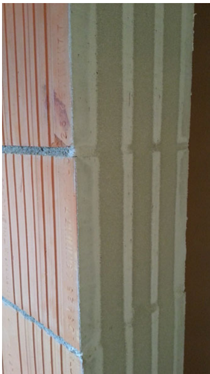
Wyrównany zaprawą termoizolacyjną illbruck PR005 gładź otworu okiennego
