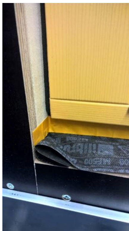
4. Zaizolowanie dolnego złącza folią okienną w narożu.
