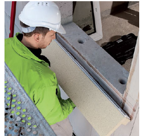
Rys.6 Starannie docisnąć kątowniki instalacyjne PR010 do muru i wyrównać je
