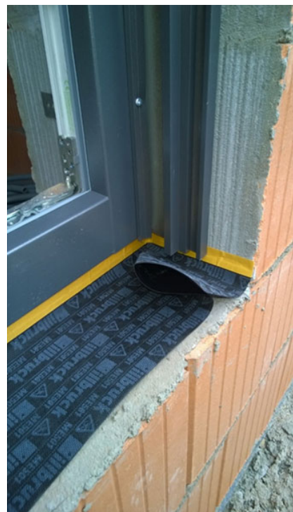
Okno zamontowane w uprzednio przygotowany i wyrównany otworze okiennym
